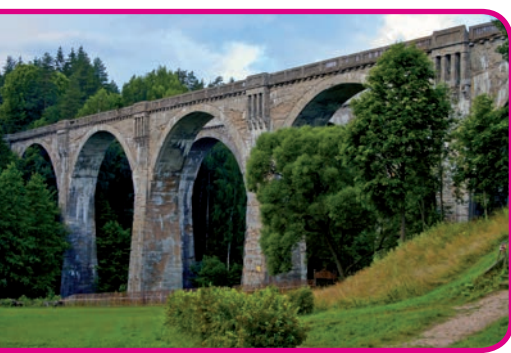
Wiadukt kolejowy, fot. GEP Chroszcz
